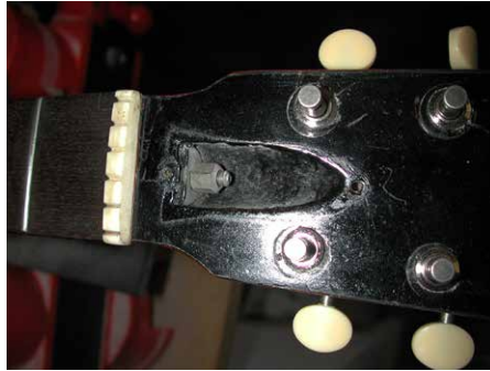
Zugang zur Einstellschraube vom Kopf aus (hier nicht als Inbusschraube, sondern als normale Mutter ausgeführt)
